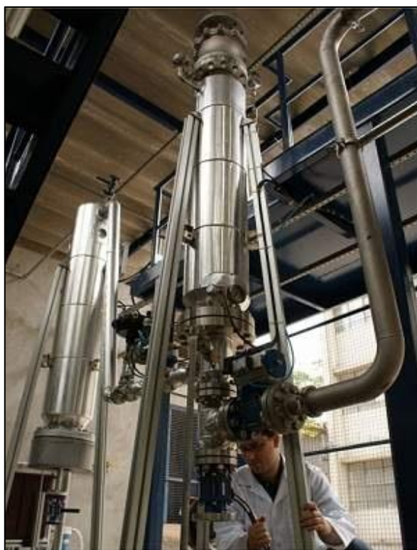
Figura 5: Reator de explosão a vapor, IPT SP.
