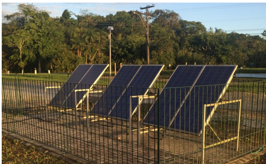
FIGURA 13 - Painéis solares instalados no Bloco I da Univille (campus Joinville).
