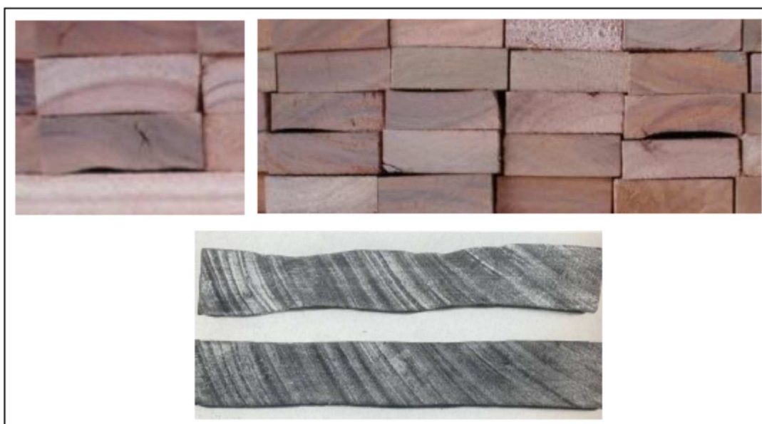
Figura 9 - Ilustração da aparência da madeira com colapso.
