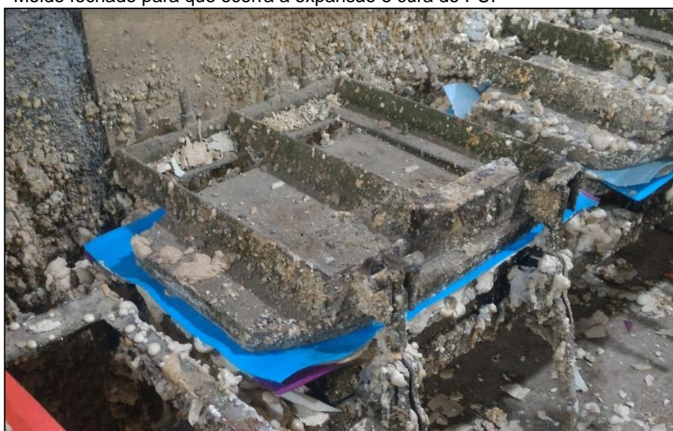
Figura 10 - Molde fechado para que ocorra a expansão e cura do PU.
