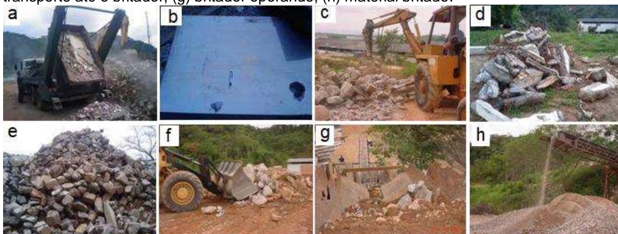
Figura 21 - Etapas de recebimento e preparação dos resíduos: (a) veículo de transporte; (b) material a ser rompido; (c) rompimento; (d) trama de ferro; (e) material rompido; (f) transporte até o britador; (g) britador operando; (h) material britado.
