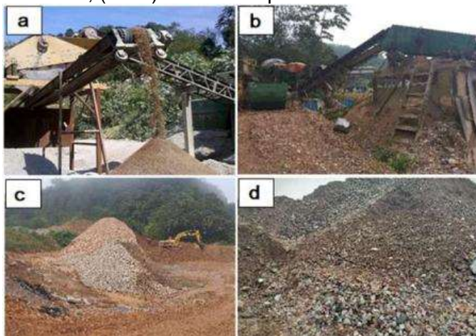
Figura 23 – Locais de armazenamento dos resíduos: (a) vista geral do britador, (b) esteira que conduz o material britado, (c e d) material depositado in loco
