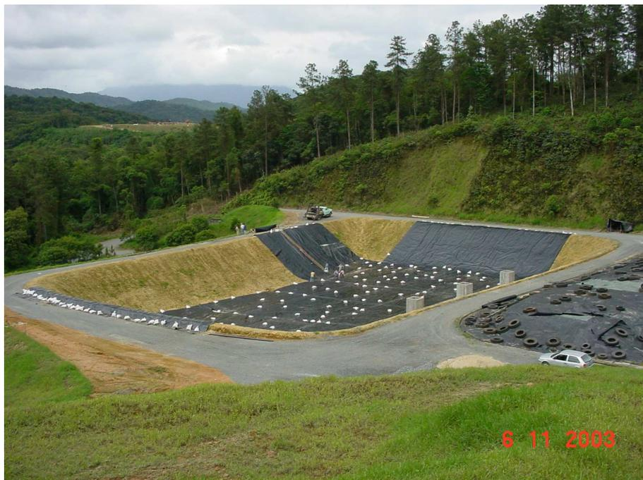
**Figura 24** – Vista da segunda trincheira sendo impermeabilizada.
