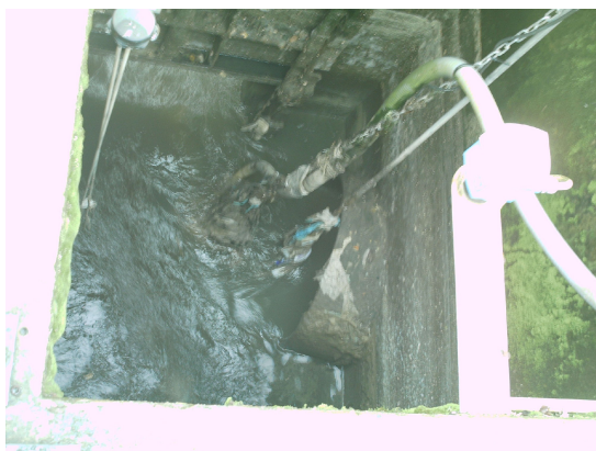
Figura 7 – Coleta de água residuária civil/mista para a alimentação da estação experimental
