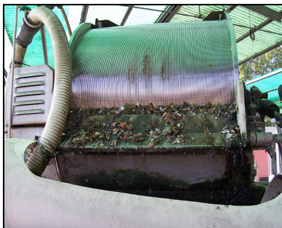
Figura 9 – Peneira móvel de fluxo tangencial
