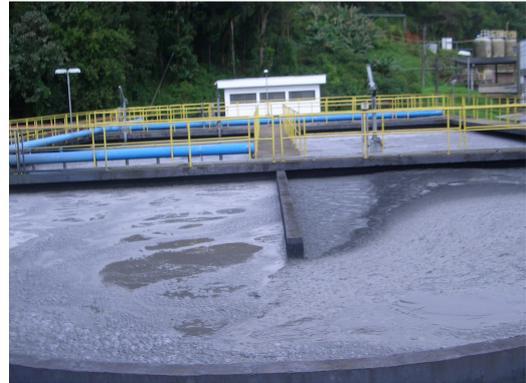
**Figura 10:** Digestor aeróbio CARROSSEL.
