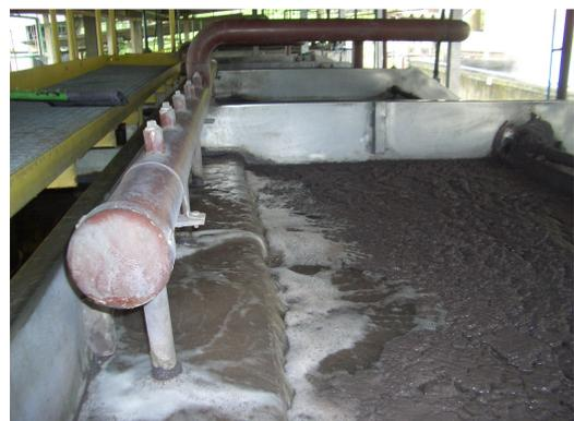
**Figura 13:** Flotador.
