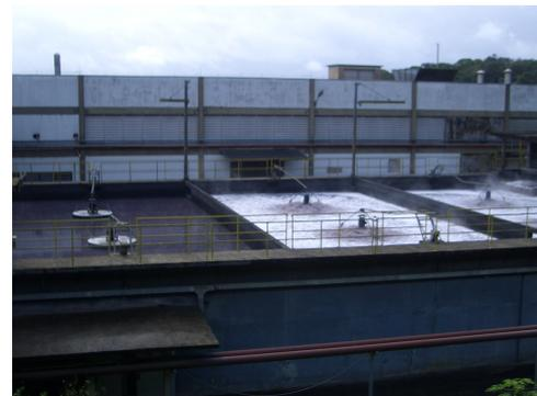
**Figura 08:** Tanque de Equalização e Neutralização.
