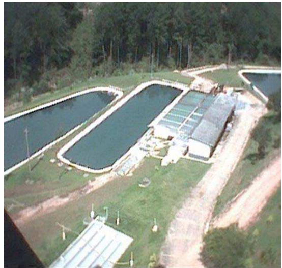
Figura 10. Estação de tratamento de efluentes
