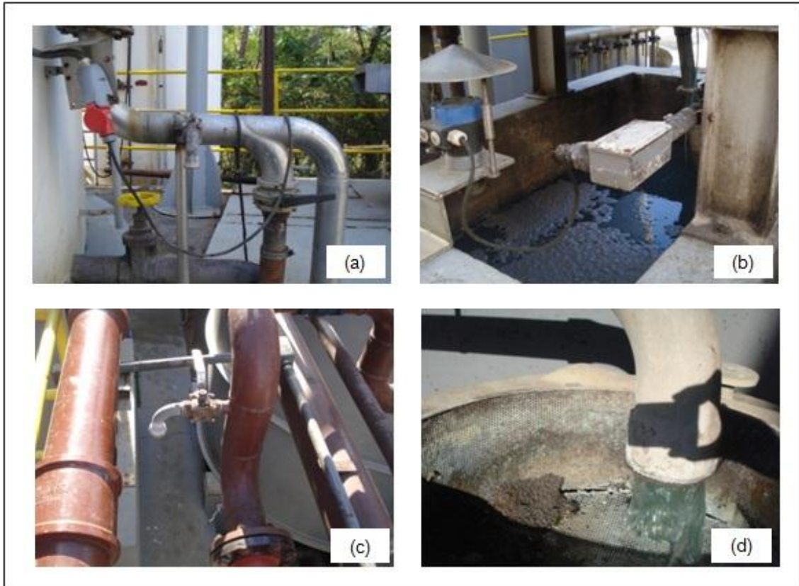
Figura 16 – Pontos de coletas de amostras: (a) após o tanque de equalizador; (b) na calha Parshall; (c) após o reator 60 e (d) após o reator 61.
