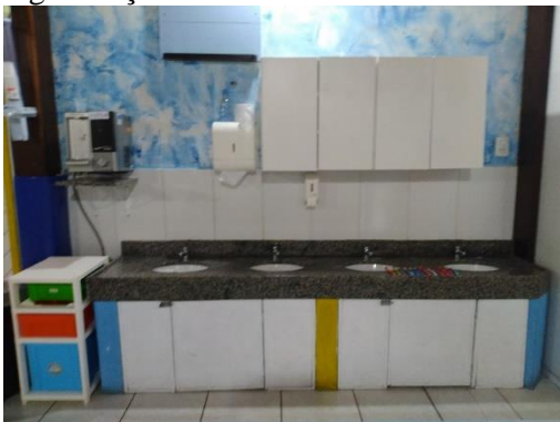
Figura 4 – Vista parcial da pia coletiva de higienização
