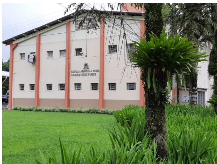
Figura 2 – Imagem Externa do prédio da Escola Agrícola Municipal Carlos Heins Funke em Joinville/SC
