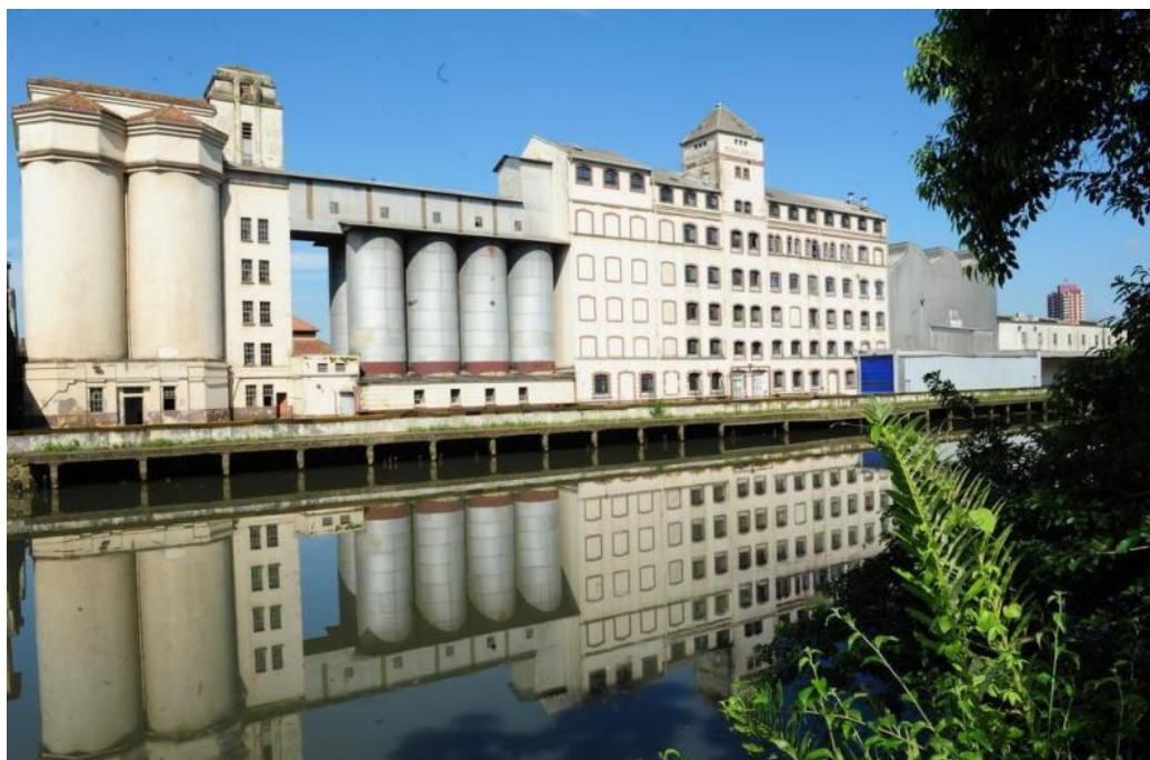
Figura 10: Empresa Bunge – instalada nas margens do rio Cachoeira
