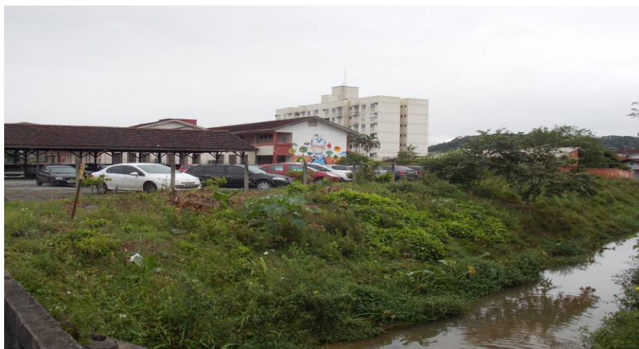
Figura 13 – Escola Municipal “Governador Pedro Ivo Campus” às margens do rio Cachoeira
