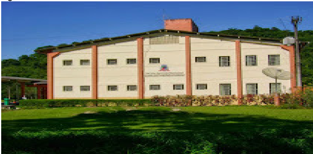
Figura 3: Fachada da escola
