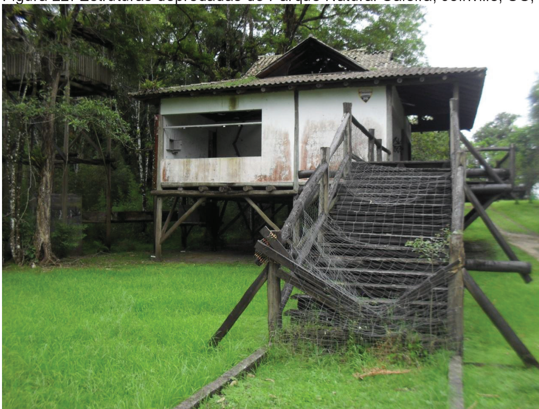
Figura 22: Estruturas depredadas do Parque Natural Caieira, Joinville, SC, 2017
