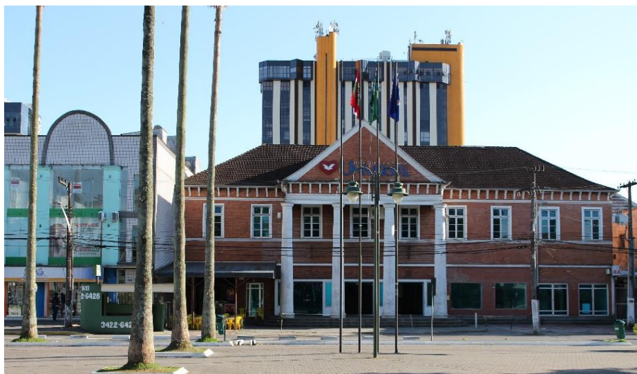
Figura 28 – Fachada atual do Cine Palácio
