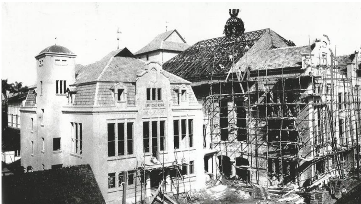
Figura 4 – Obra em Andamento do Edifício
