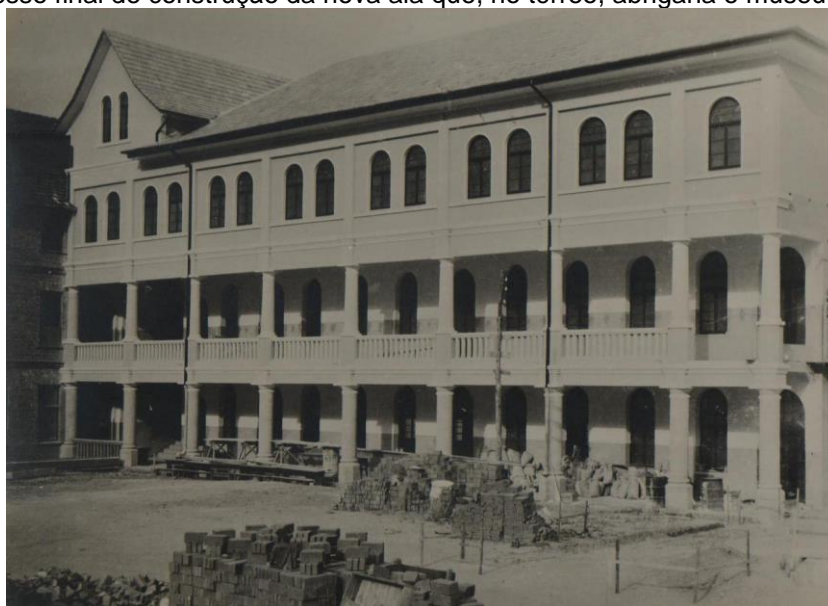
Figura 11 – O processo final de construção da nova ala que, no térreo, abrigaria o museu, 1952
