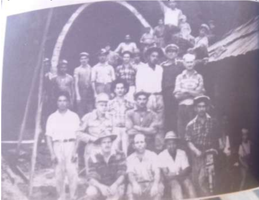
Figura 4 – Imagem de Civis e militares na construção da ferrovia Mafra - Lages
