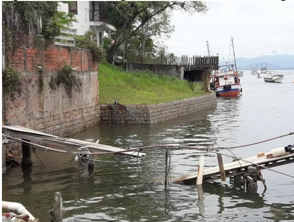
Figura 4: Detalhe de alguns muros de arrimo, nas margens da Baía de Guaratuba, no Bairro Piçarras
