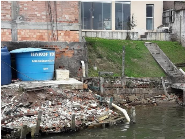
Figura 3: Detalhe em que aparece cano de esgoto indo até as águas, nas margens da Baía de Guaratuba, no Bairro Piçarras.
