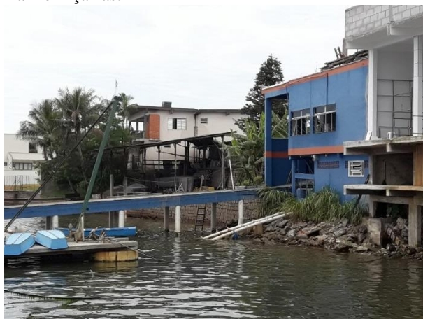
Figura 1: Muros de arrimo e restos de construção usados para aumentar as margens da Baía de Guaratuba no Bairro Piçarras.
