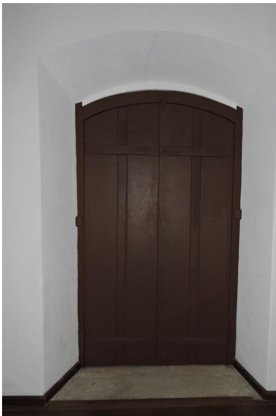
Figura 8 – Espessura da parede da Igreja Matriz Nossa Senhora da Graça, em São Francisco do Sul (SC)
