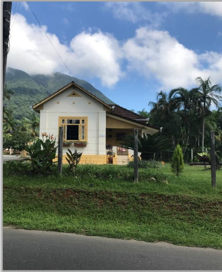
Figura 6 – Antiga edificação localizada na Estrada Mildau.
