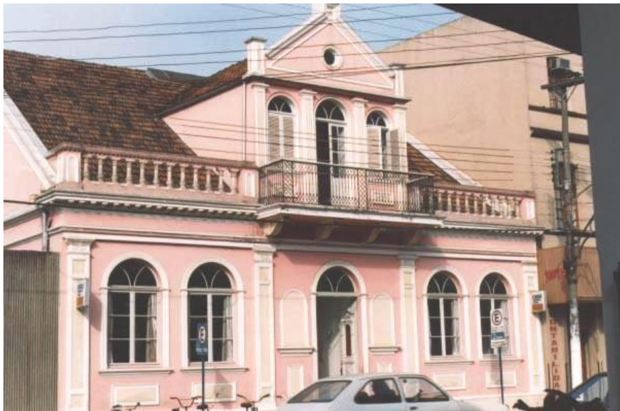
Figura 48 - Casa Konder, foto da década de 1990
