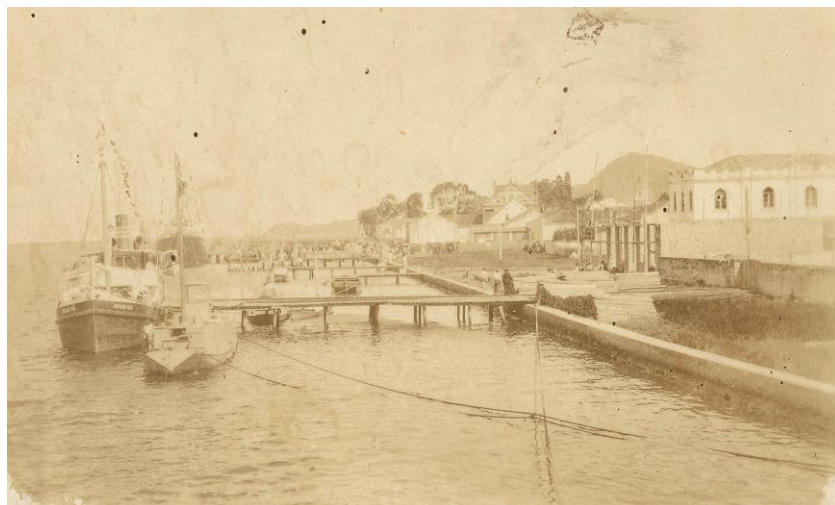
Figura 13 - Cais do Porto de Itajaí, 1930
