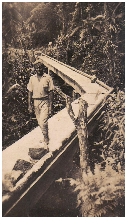
Trabalhador durante obras no continente 9
