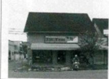
Imagem 08. Vista da fachada frontal da Edificação 01. Fonte: CPC/FCJ. Data: 09.11.2009.
