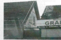
Imagem 12. Detalhe da fachada sul da Edificação 01. Fonte: CPC/FCJ. Data: 09.09.2013.
