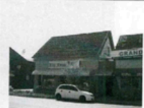
Imagem 09. Vista da fachada frontal da Edificação 01. Fonte: CPC/FCJ. Data: 09.09.2013.
