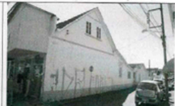
Imagem 46. Vista da fachada sul da edificação da Av. Getúlio Vargas, 1369. Fonte: CPC/FCJ. Data: 28.03.2016.
