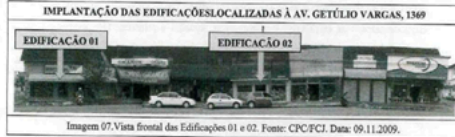
Imagem 07. Vista frontal das Edificações 01 e 02. Fonte: CPC/FCCI. Data: 09.11.2009.
