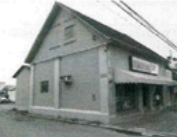
Imagem 13. Detalhe das fachadas frontal e norte da Edificação 01. Fonte: CPC/FCJ. Data: 09.11.2009.
