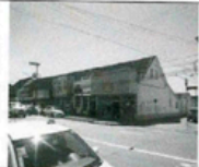
Imagem 45. Vista das fachadas principal e sul da edificação da Av. Getúlio Vargas, 1369. Fonte: CPC/FCJ. Data: 28.03.2016.
