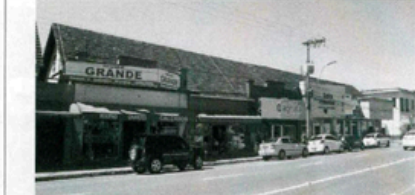
Imagem 42. Vista da fachada principal da edificação da Av. Getúlio Vargas, 1369. Fonte: CPCFCJ. Data: 28.03.2016.
