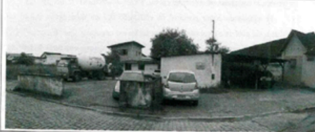
Imagem 22 Detalhe da fachada posterior da Edificação 01 e dos diversos anexos que existem no terreno, nos fundos. Fonte: CPC/FCJ. Data: 09.11.2009.
