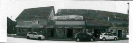
Imagem 10. Vista da fachada frontal da Edificação 01, em continuidade volumétrica com a Edificação 02. Fonte: CPC/FCJ. Data: 09.09.2013.
