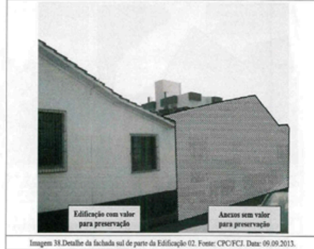
Imagem 38. Detalhe da fachada sul de parte da Edificação 02. Fonte: CPC/FCI. Data: 09.09.2013.
