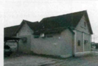
Imagem 14. Detalhe das fachadas norte e posterior da Edificação 01. Fonte: CPC/FCJ. Data: 09.11.2009.
