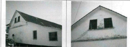
Imagem 36. Detalhe da fachada sul de parte da Edificação 02. Fonte: CPC/FCI. Data: 09.09.2013.
