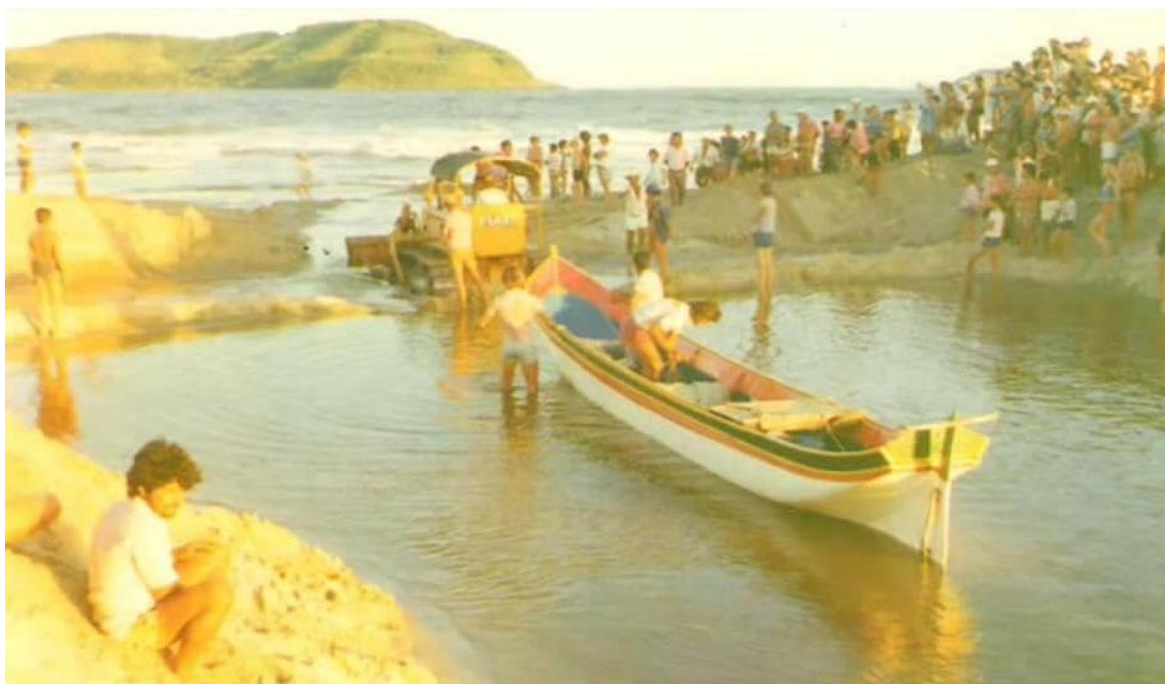
Figura 42 – Trabalhos na abertura dos molhes de pedra. Balneário Barra do Sul (SC), década de 80
