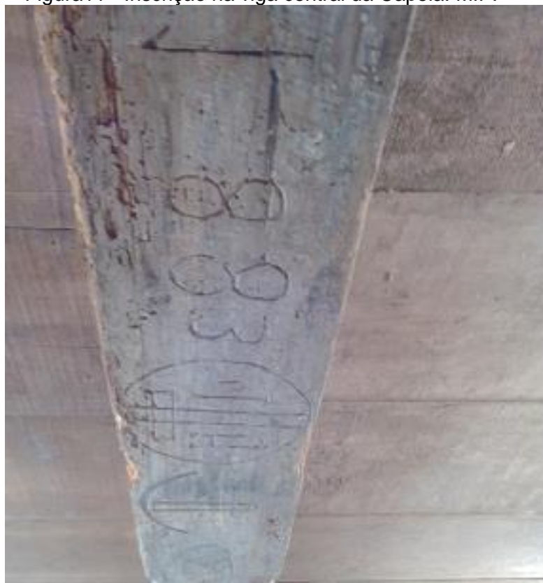
Figura11 - Inscrição na viga central da Capela. MIP.
