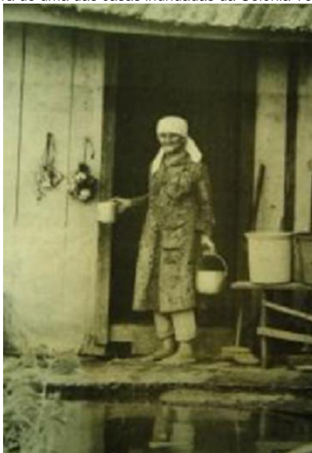
Figura 3 - Moradora de uma das casas inundadas da Colônia Tomás Coelho, 1987.
