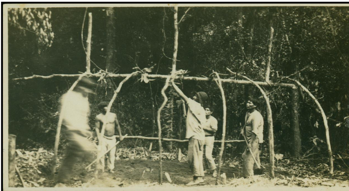
Figura 74: Início da construção de uma moradia Laklãnõ/Xokleng.
