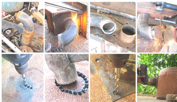
Figura 26 – Adequação do duto de exaustão.
