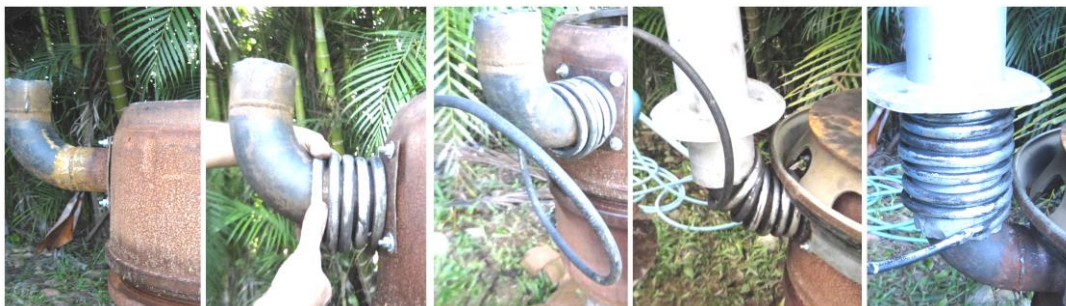
Figura 27 – Serpentina adaptada ao redor do duto de exaustão.
