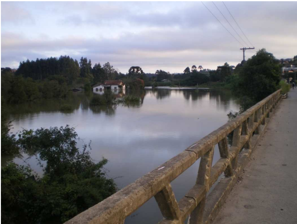
Figura 2 – Área inundada pelo Rio dos Bugres sob a ponte na BR 280, Rio Negrinho-SC
