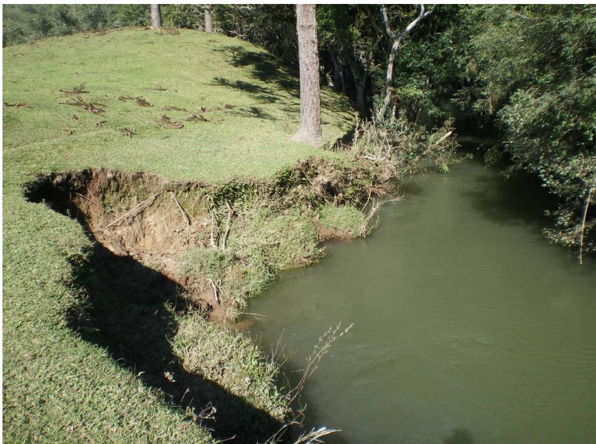
Figura 19 – Margem ciliar do Rio dos Bugres em processo de deslizamento do barranco em uma propriedade de pesque-pague.
