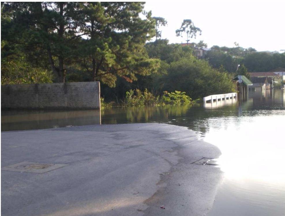
Figura 3 – Área inundada pelo rio dos Bugres sobre a ponte do rio localizada no bairro Quitandinha. À esquerda está situada uma empresa de lavação de automóveis, Rio Negrinho-SC
