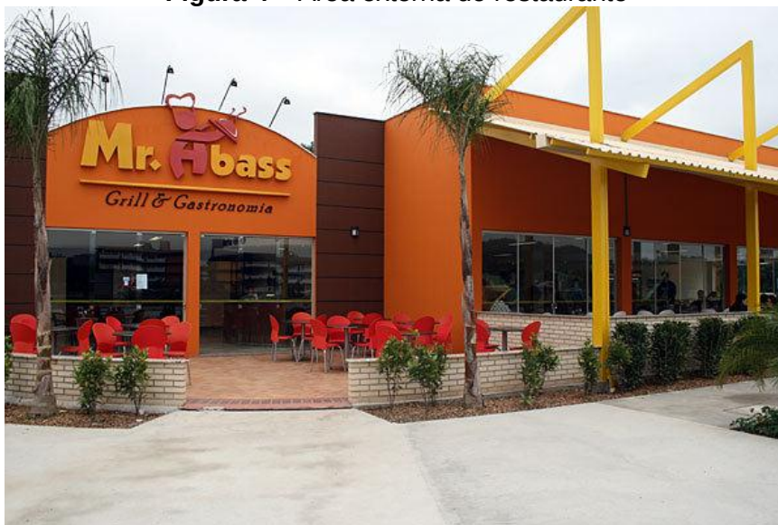
Figura 4 – Área externa do restaurante
