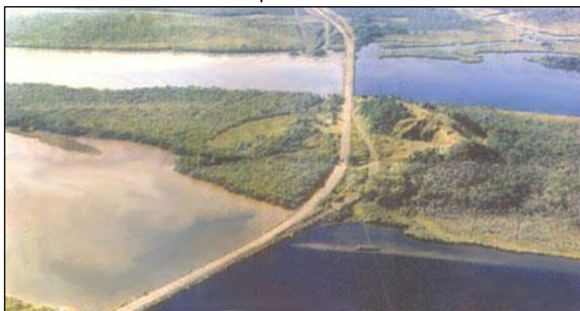
Figura 20 – Vista geral do aterro. Diferença da coloração da água à esquerda, no lado da baía, devido ao intenso processo de assoreamento
