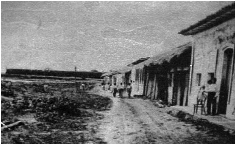
Rua da Praia, 1910 - Vila de São José de Macapá. Fonte: Museu da Imagem e do Som – MIS
