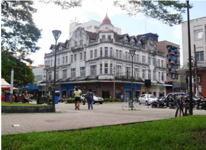
Figura 2: Primeiro prédio com projeto de restauração
