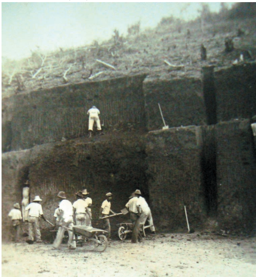
Figura 3 – Trabalhos de terraplanagem para a construção da caixa-d'água da Base Naval da Ilha da Rita (1937)
