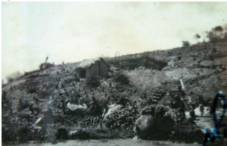
Figura 10 – Início da construção da casa do comando da base naval (1937)
