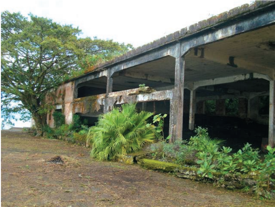
Figura 12 – Fotografia do prédio que serviu de alojamento aos fuzileiros e depósito de carvão (2013)
