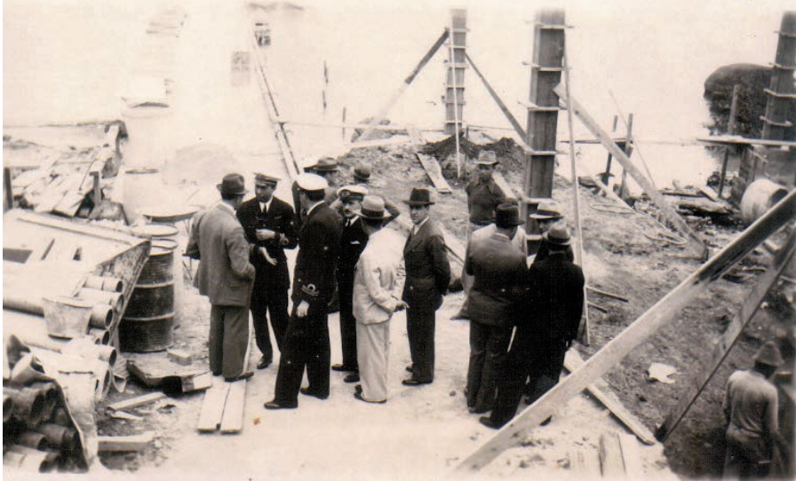
Figura 9 – Visitas oficiais às obras de construção da Base Naval da Ilha da Rita (s.d.)
