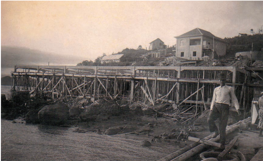
Figura 7 – Estrutura para a construção do alojamento e do depósito de carvão da Base Naval da Ilha da Rita [1938?]
