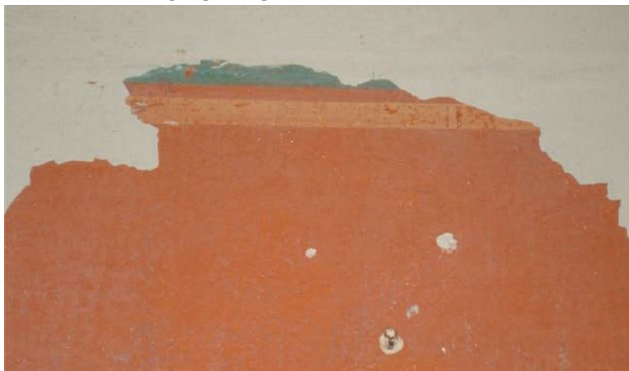
Figura 11 – Remanescente de pintura original da casa de comando da Base Naval da Ilha da Rita, com prospecção pictórica
