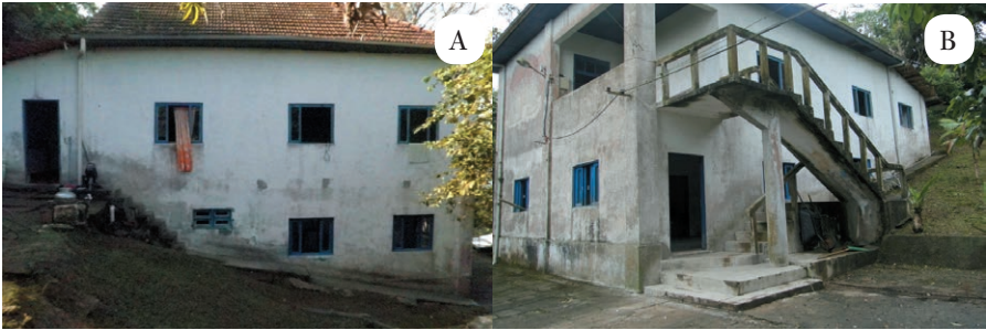
Figura 2 – A e B: fotos atuais da antiga residência do posto de comando da base naval (2011)
