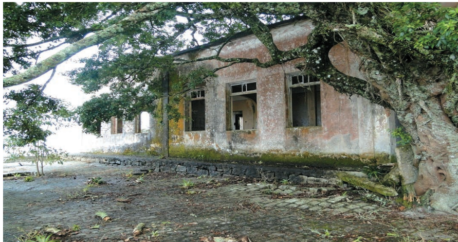
Figura 9 – Fotografia do prédio do alojamento da Base Naval da Ilha da Rita: vista externa com detalhes da degradação natural e antrópica
