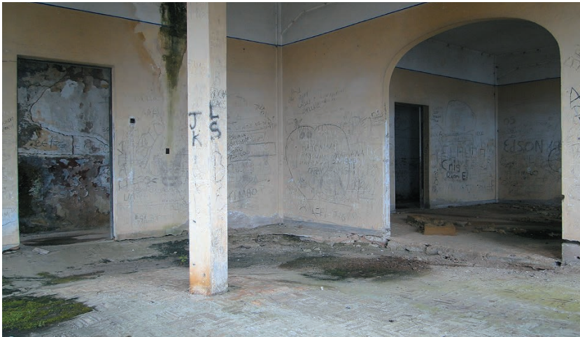
Figura 11 – Salões do alojamento de fuzileiros, com inscrições nas paredes, infiltrações e marcas no antigo piso, em tacos de madeira, retirado para alimentar fogueiras
