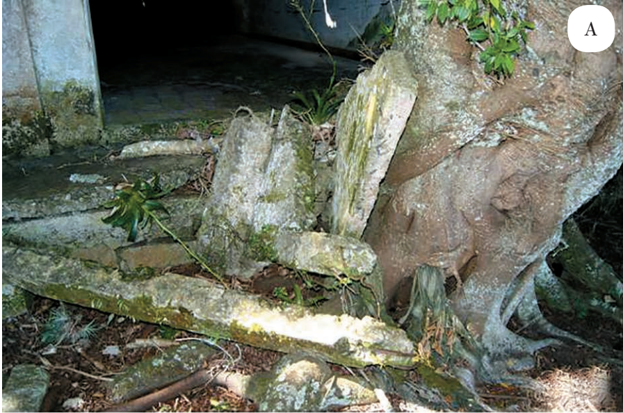
Figura 8 – Danos provocados às edificações históricas da Ilha da Rita pelo crescimento de árvores de Ficus organensis (Moraceae) – A: erguimento da fundação de concreto; B: rachadura em parede
