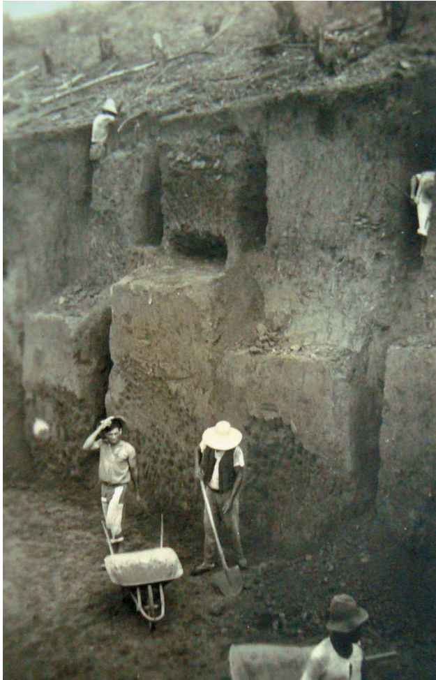
Figura 4 – Homens trabalhando no preparo do terreno para a construção de um dos tanques da Base Naval da Ilha da Rita (1937)
