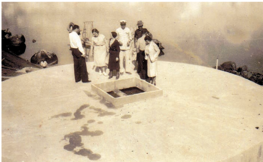
Figura 16 – Mulheres visitando as obras de construção da Base Naval da Ilha da Rita (s.d.)
