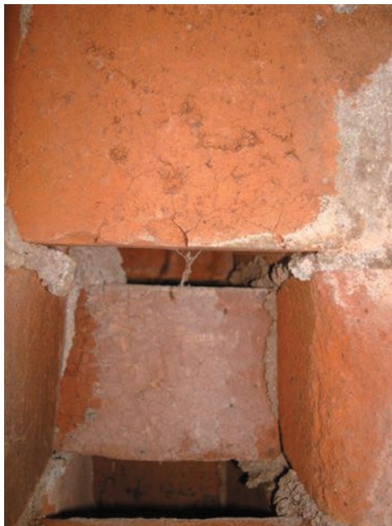
Figura 15 – Detalhe construtivo da edificação do alojamento de fuzileiros – tijolos cruzados
