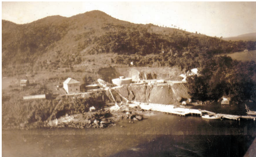
Figura 5 – Vista das obras de construção da Base Naval da Ilha da Rita [1938?]
