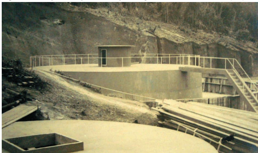
Figura 6 – Em primeiro plano o tanque de água e, ao fundo, o de óleo (s.d.)
