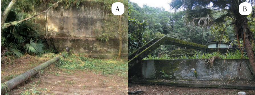
Figura 5 – A: tanque de óleo combustível; B: tanque de água da antiga base naval
