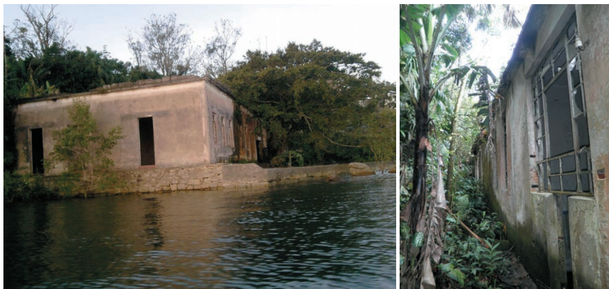
Figura 4 – Alojamento dos fuzileiros – vista da baía e fundos da edificação (área de descarte)
