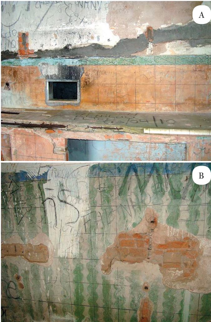
Figura 14 – Detalhes de pinturas na cozinha (A) e sanitários (B)
