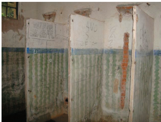
Figura 12 – Cabines para banho dos sanitários do alojamento
