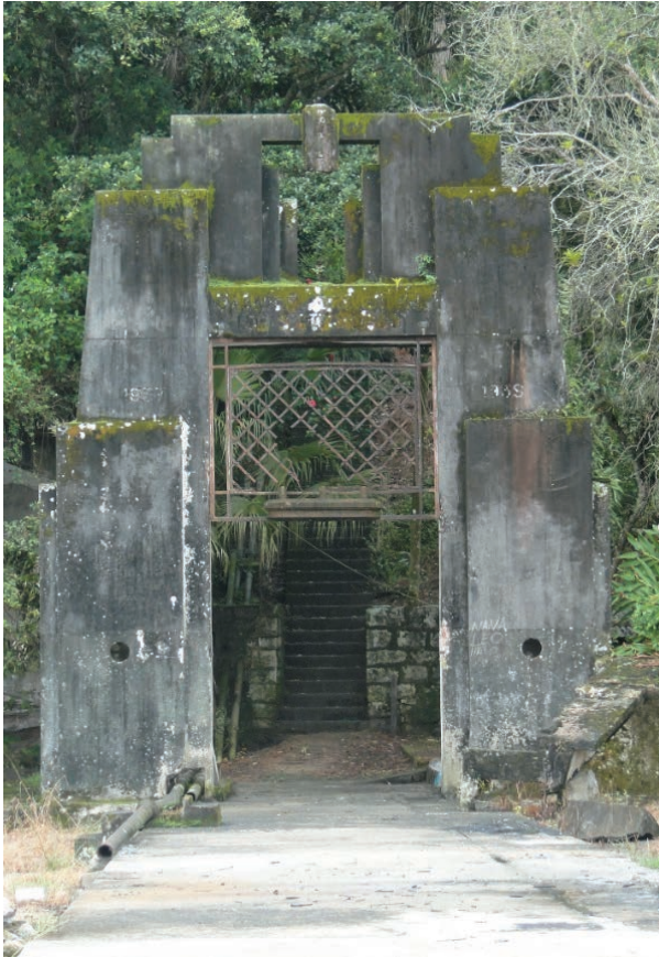
Figura 15 – Pórtico da base, início da escadaria e ao lado tubos de água da antiga Base Naval da Ilha da Rita
