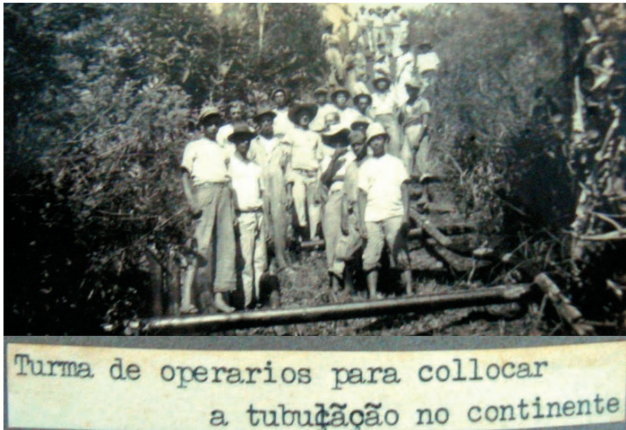
Figura 2 – Operários contratados para colocar a tubulação de água no continente em direção à Ilha da Rita (1937)
