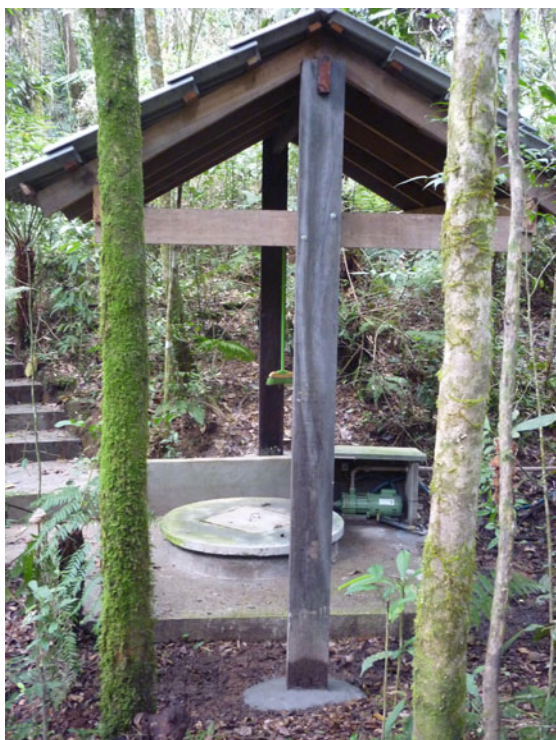
Fotografia 1 – Poço raso com anel sanitário
