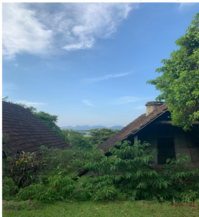
Figura 2 - Vista do telhado dos fornos da caieira, ao fundo a Lagoa do Saguaçu, 2024
