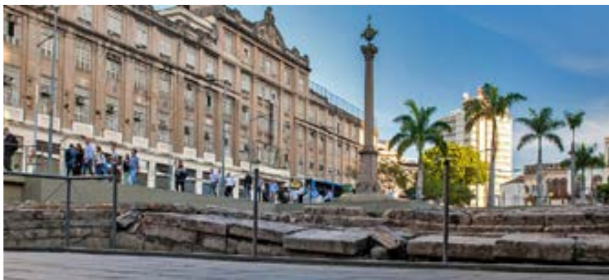
Figura 3 – Cais do Valongo, Rio de Janeiro (RJ)
