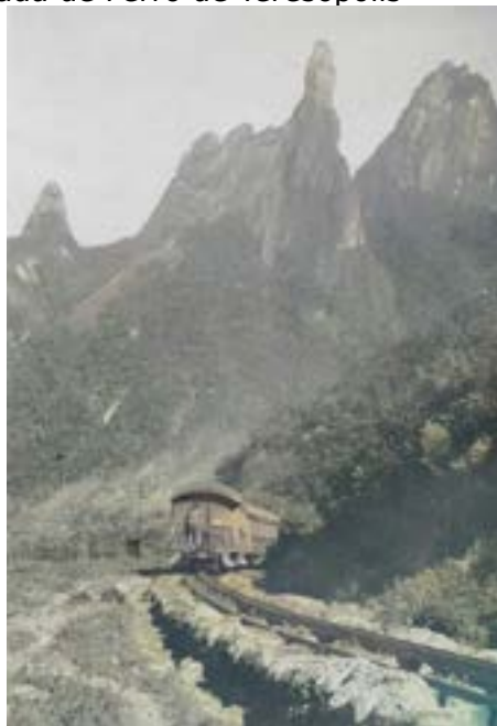
Figura 3 – Estrada de Ferro de Teresópolis
