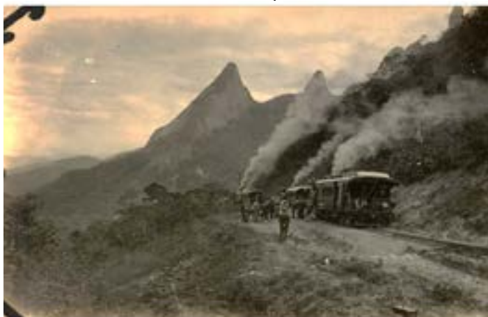
Figura 2 – Estrada de Ferro de Teresópolis
